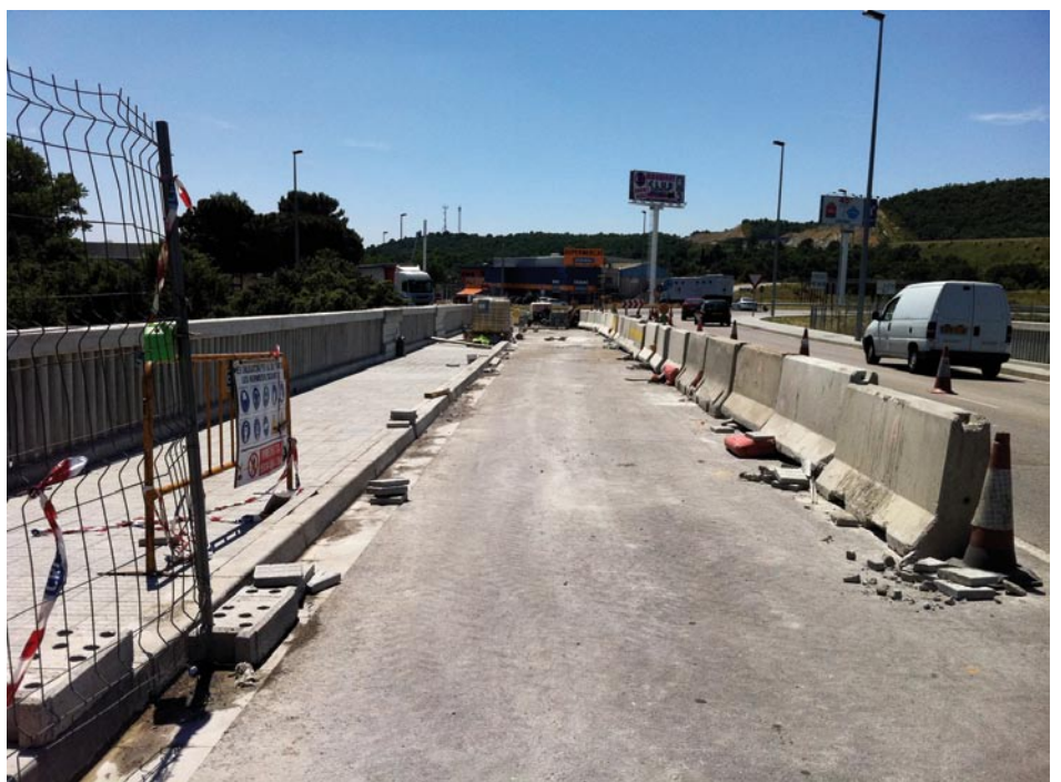
• Obres al pont de la carretera N2 sobre el Llobregat al sector de la duana i estació de servei BP (Foto: Infojonquera.cat)
