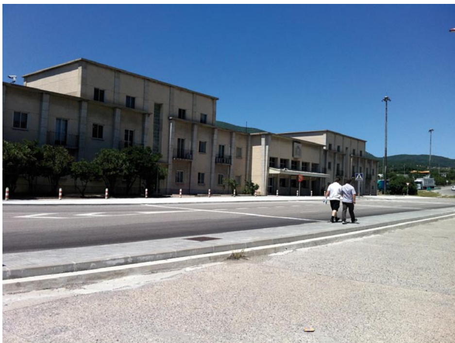
• L'edifici de la duana podria acollir una oficina provisional dels Mossos d'Esquadra (Foto: Infojonquera.cat)
