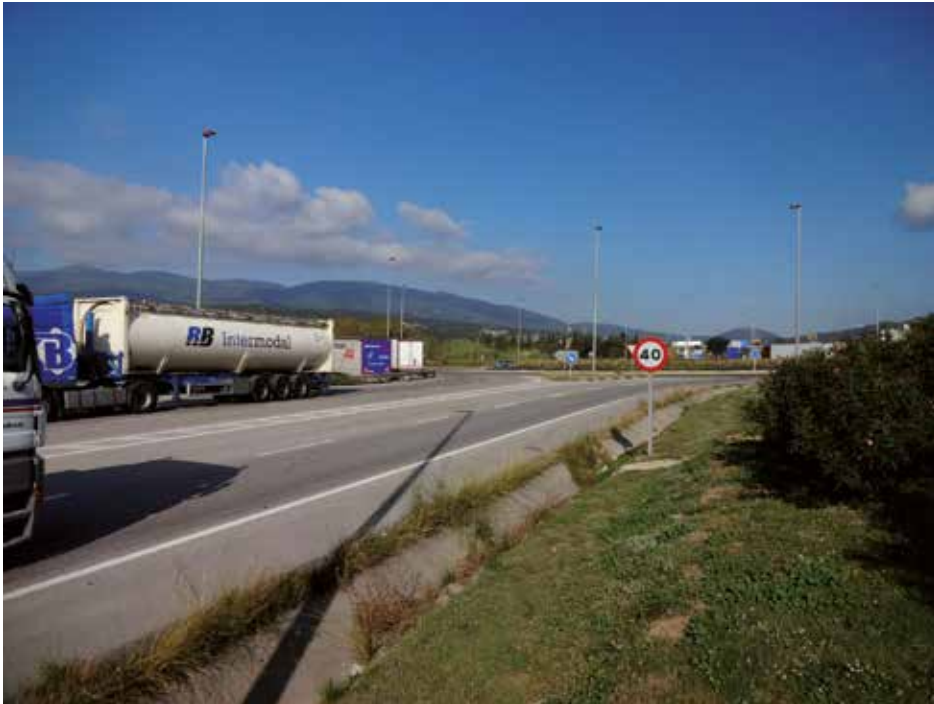
• Tram de l'N-II a la Jonquera, desdoblament parcialment per trams no continuats. Les obres per un desdoblament definitiu hauran d'esperar uns quants anys per manca de partides pressupostàries. (Infojonquera.cat)
