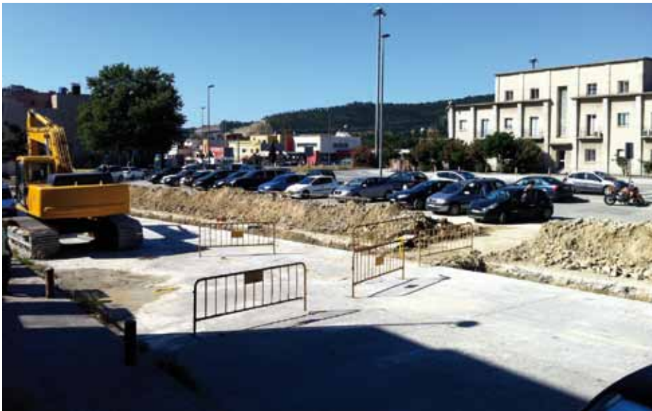
• Obres a l'aparcament de la duana, antiga campa d'exportació. L'oposició ha demanat que l'empresa constructora compleixi amb les normatives de seguretat i d'obertura de noves rases © Infojonquera.cat
