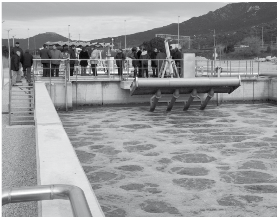
• Nova depuradora de la Jonquera, rebent visites oficials el passat gener. Aviat substituirà en funcions la depuradora de Vilella (Falgüés Fotografia)
