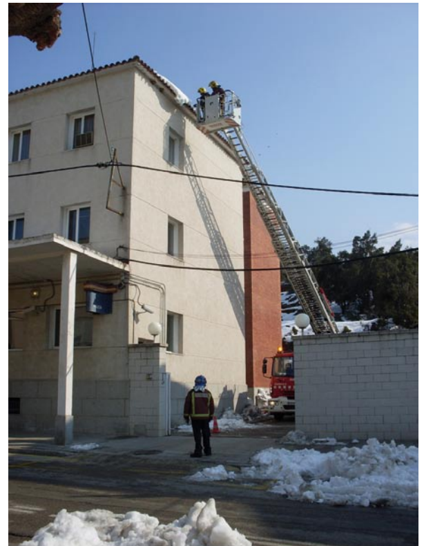
• Retirant congestes de neu dels teulats el dimecres 10 (Foto: P. Puigsegur)
