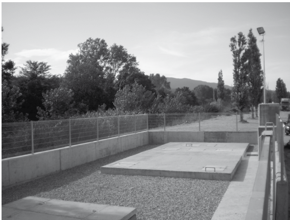
• L'antiga depuradora del polígon Vilella és ara una estació receptora per donar servei al nou col·lector (Foto: L'Esquerda)
