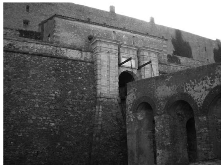
• Porta principal d'accés a Bellaguarda (Foto L'Esquerda).
