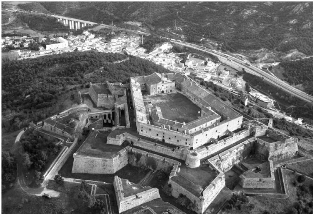
• Vista aèria actual (2008) del castell o fort de Bellaguarda (Foto: Eduardo Romo - www.zepellinfotos.com)
