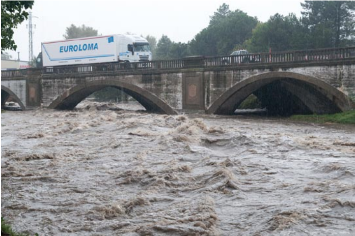
• Els tres ulls del pont de la N2 a l'alçada del cementiri van absorbir sense problemes el cabal
