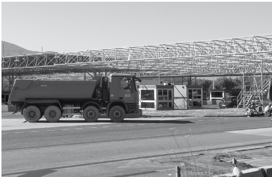
• Camions i operaris treballant per desmuntar les instal·lacions duaneres i frontereres de l'AP7 al Portús (Falgües Fotografia)
