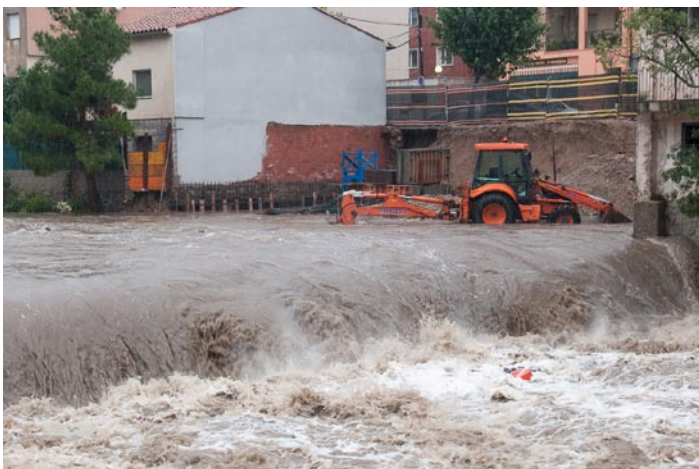
• La màquina que treballava a l'alçada de la resclosa de correus voltada d'aigua
