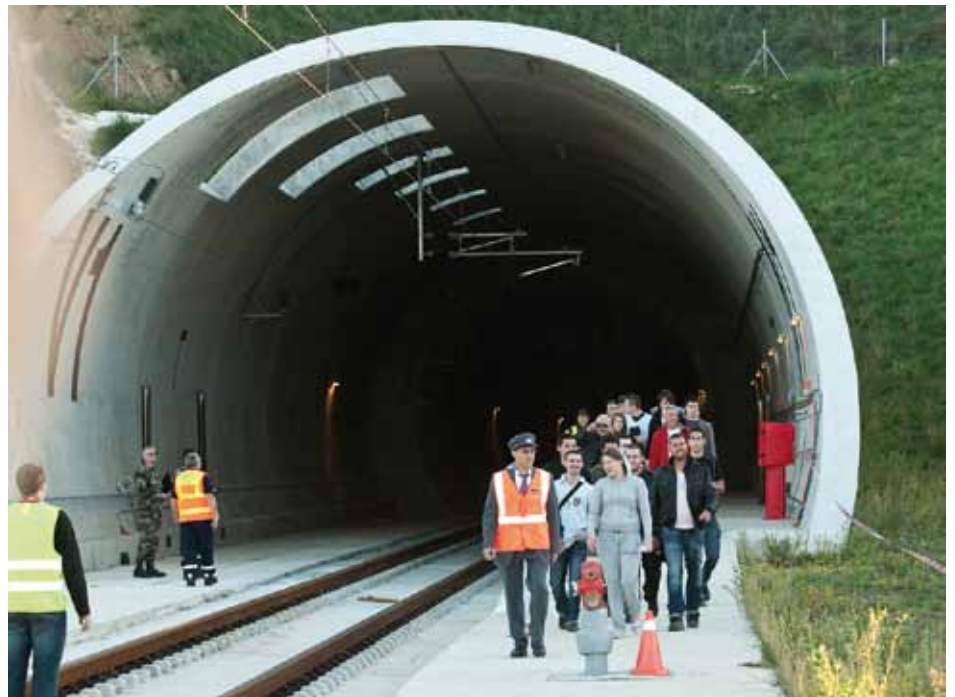
• Simulacre d'evacuació a la boca nord del Túnel del Portús el 6 de novembre (Falgués Fotografia)
