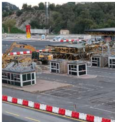
• Vista general del punt fronterer de l'Ap7 (Falgües Fotografia)
