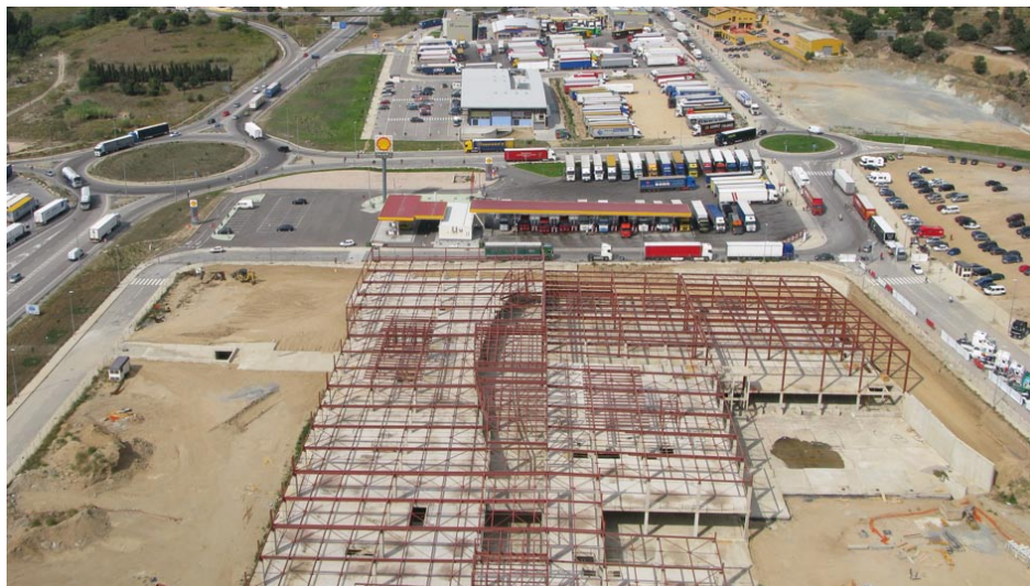
• Edifici en obres al polígon Les Oliveres, propietat del Grup Escudero (Foto arxiu ZeppelinFoto E. R.)
