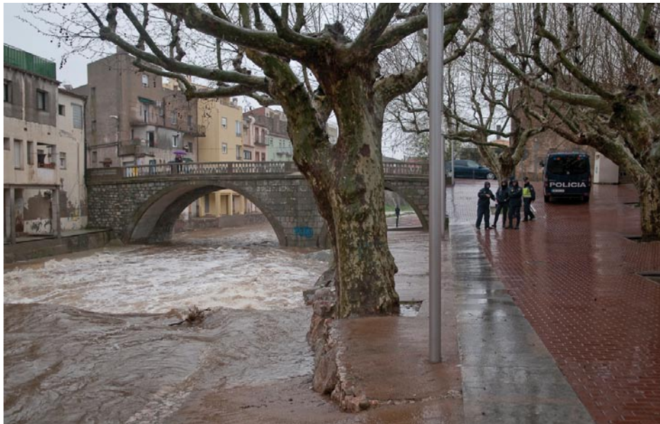
• El riu a l'alçada del pont de pedra del carrer Arias Comellas. La policia controlava l'accés al passeig del riu (Falgués Fotografia)
