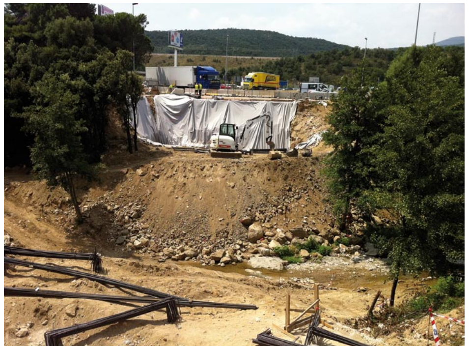
• El nou pont en construcció unirà la rotonda dels Carols-BP (magatzems venus) amb l'avinguda Pau Casals (Foto: Infojonquera.cat)
