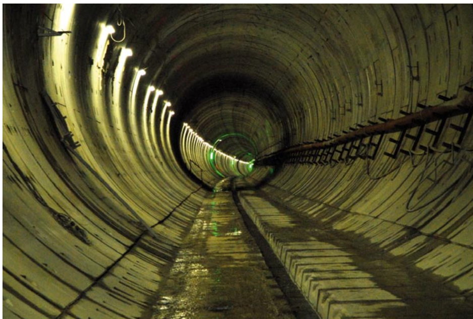
• La construcció del Túnel del TGV va necessitar un gran volum d'aigua mentre es foradava la muntanya (Arxiu Falgués Fotografia)
