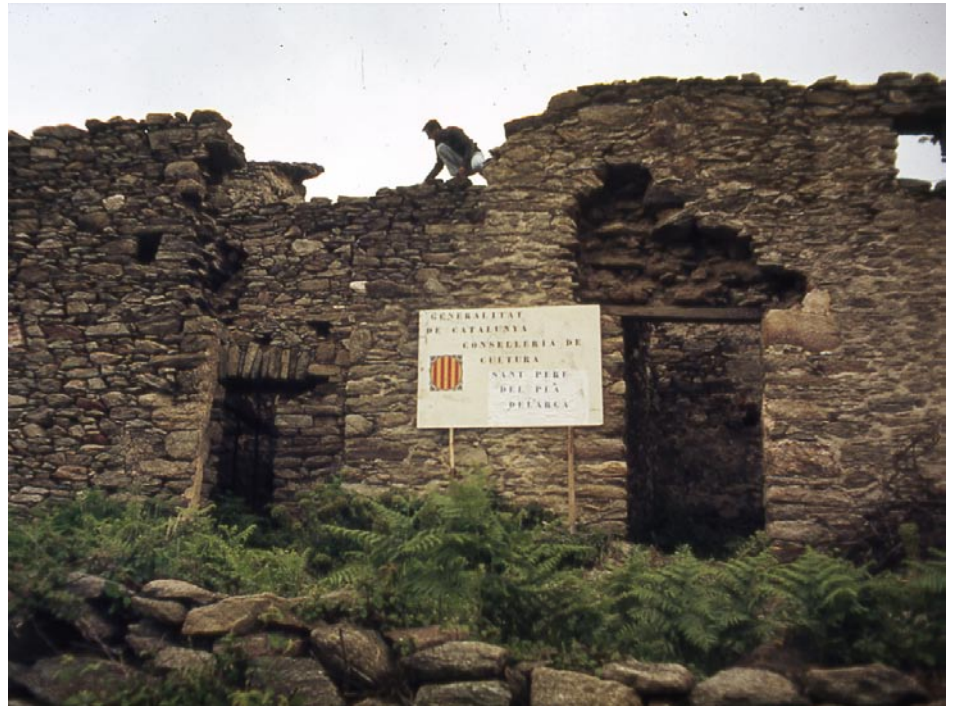
• Intervenció de consolidació a la capella de Sant Pere del Pla de l'arca (Foto GAT)
