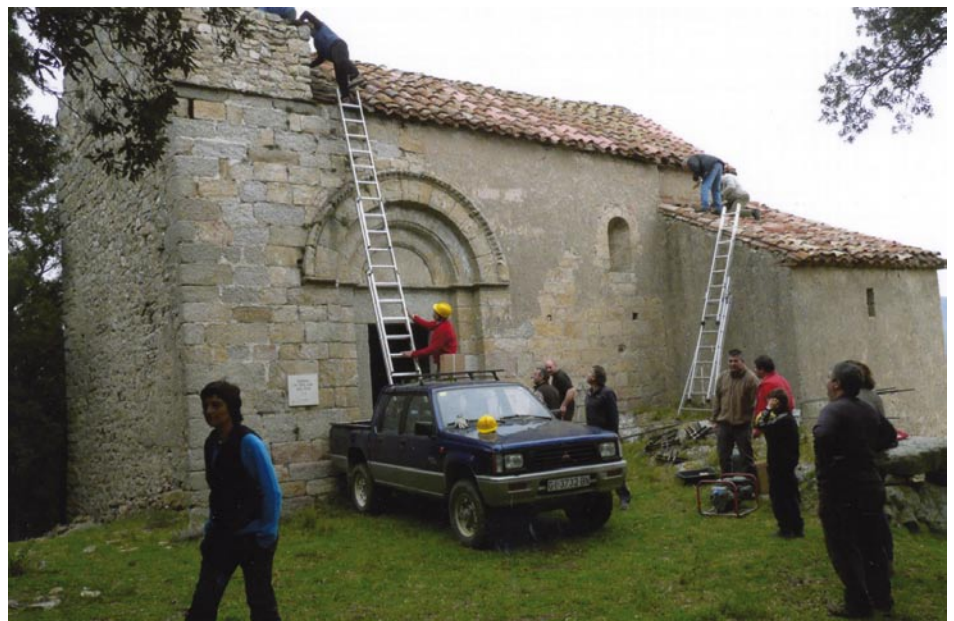
• Reparació de la teulada a la capella de Sant Julià dels Torts (Foto GAT)
