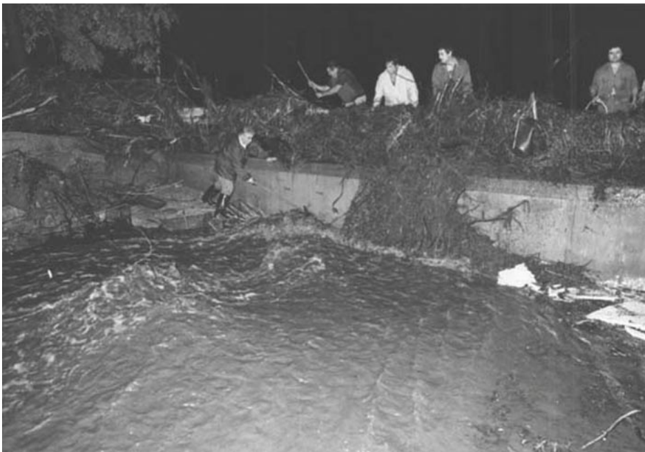
• El torrent de Santa Llúcia a l'alçada de la carretera N2. Branques i arbres van obturar el pas de l'aigua, que va buscar sortida natural pels laterals, inundant el garatge internacional i el restaurant Vista Alegre (Foto Diari de Girona - Dani Duch)
