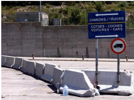
• Barrera de new jerseys en línia a la zona duana
