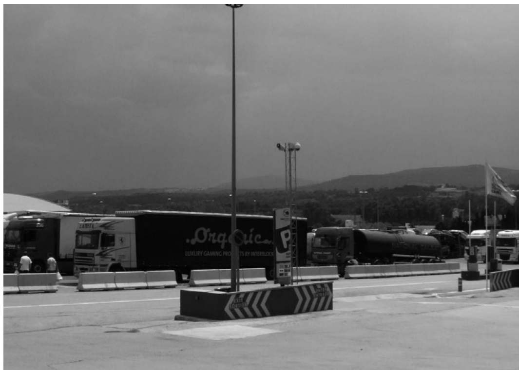
• Vista de l'aparcament de La Tortuga, equipat amb tanca perimetral i barrera d'accés amb tiquet (Foto Esquerda).
