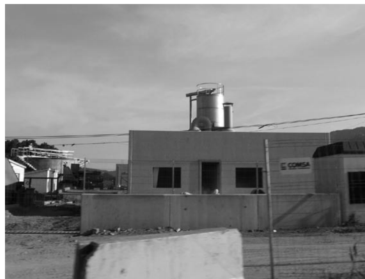
• Edifici de recepció en obres a l'entrada de la nova depuradora (Foto: Esquerda)
