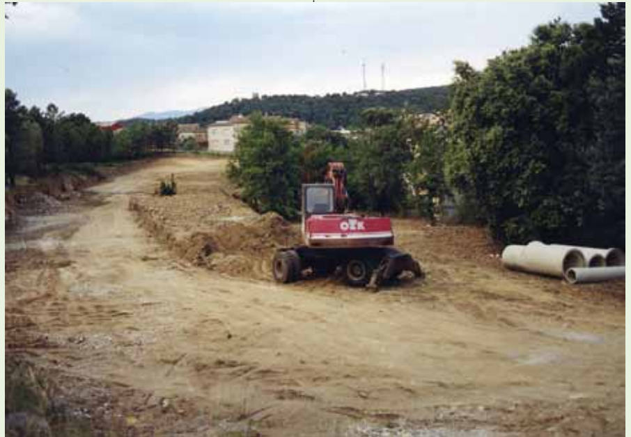
• Vista del carrer Roc de Miradones el juny de 2002. S'iniciaven les obres (Arxiu Esquerda)
