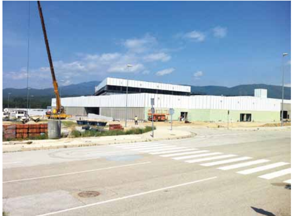
• Obres a l'edifici que acollirà el complex comercial "Gran Jonquera" (Infojonquera.cat)
