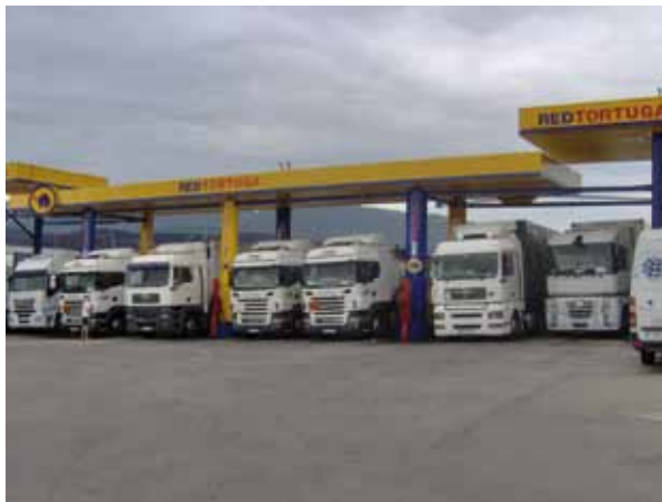
• Noves marquesines per als sortidors i il·luminació amb tecnologia LED a l'àrea de servei Tortuga de la Jonquera
