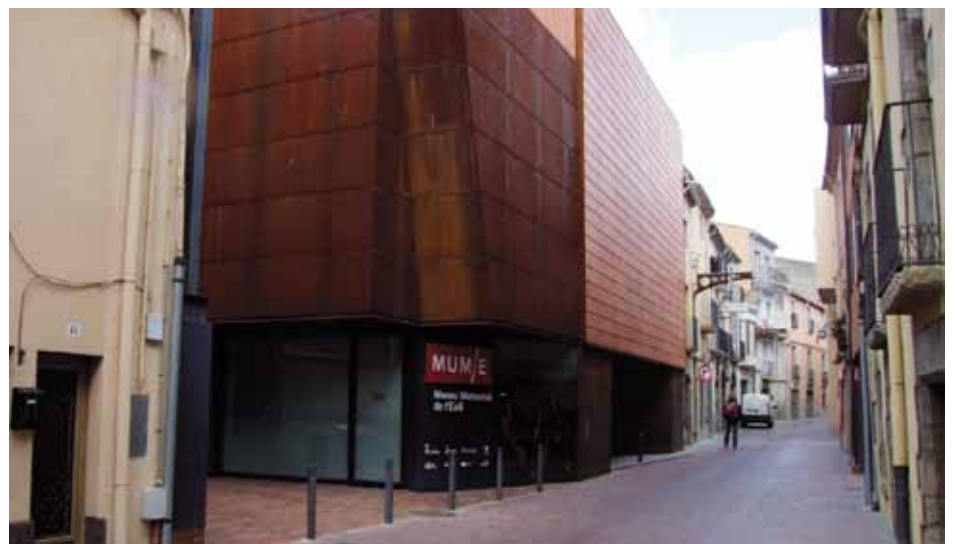
• Façana exterior del MUME (Infojonquera.cat)
