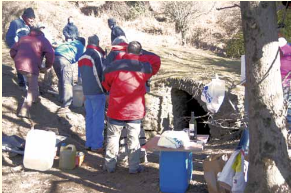
A l'esquerra, fent treballs de paletaeria a tocar del Pou de Neu A dalt, membres del GAT realitzant tasques de restauració i neteja al Pou de Nou de Puig Neulós (Fotos: GAT)
