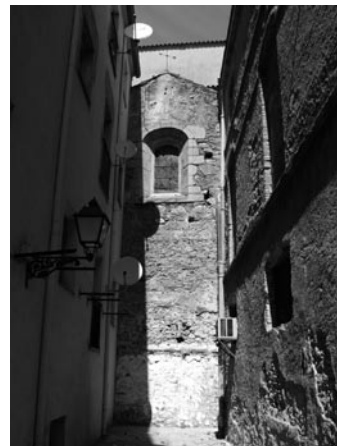
• Únic tram visible façana sud.
