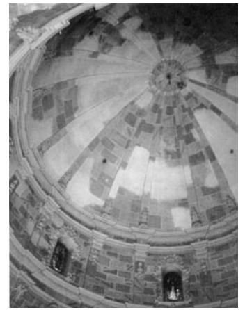
• Vista interior de la cúpula
