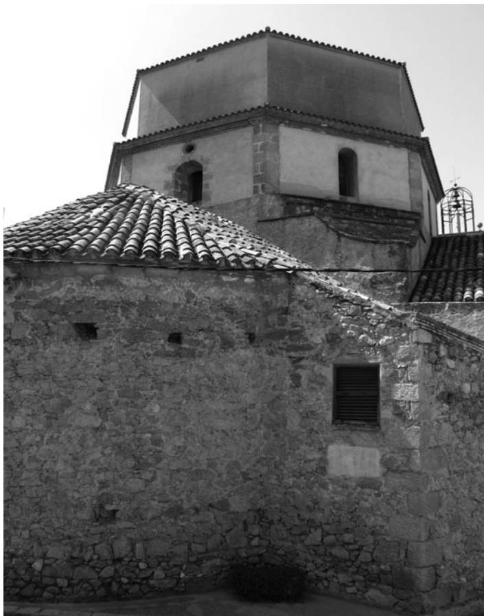
• Estat actual de la cúpula vista per la part posterior de l'edifici (Foto Esquerda)
