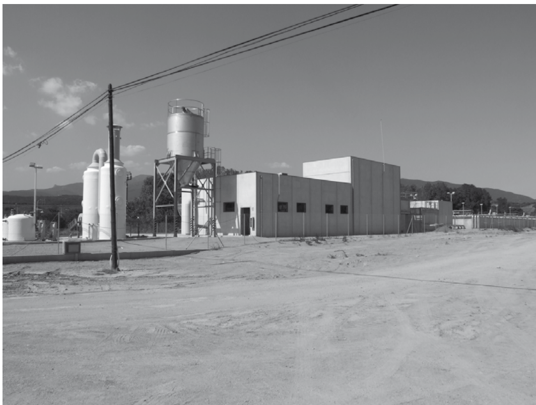
• Imatge exterior del recinte i edificis dela nova depuradora (L'Esquerda).
