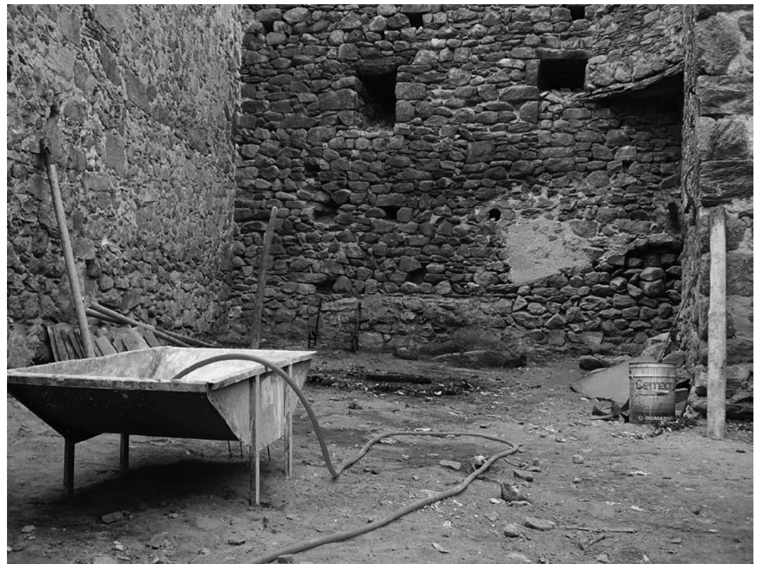
• Detall de les obres al casc històric de Cantallops (Foto particular).
