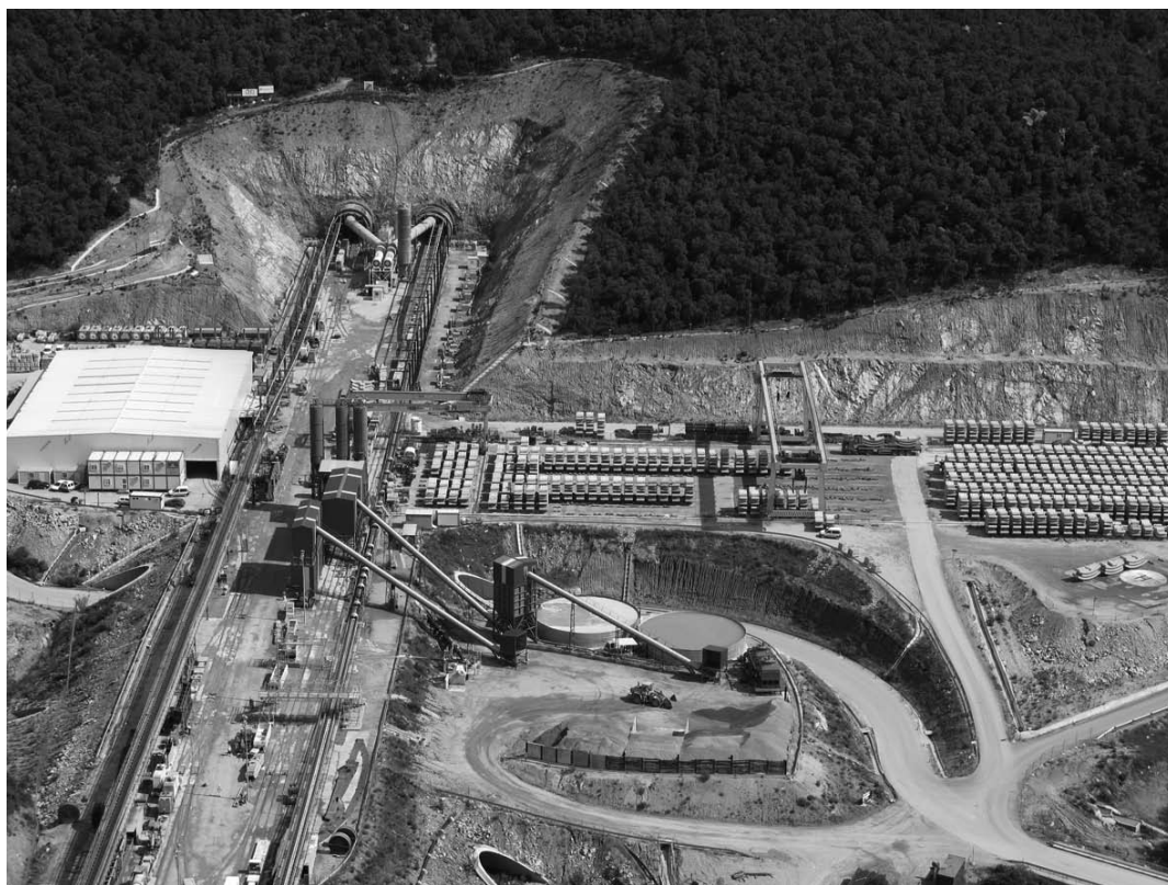
• Imatge general de les obres del túnel del Portús a la zona del Forn del Vidre (imatge d'arxiu www.zepellinfotos.com )
