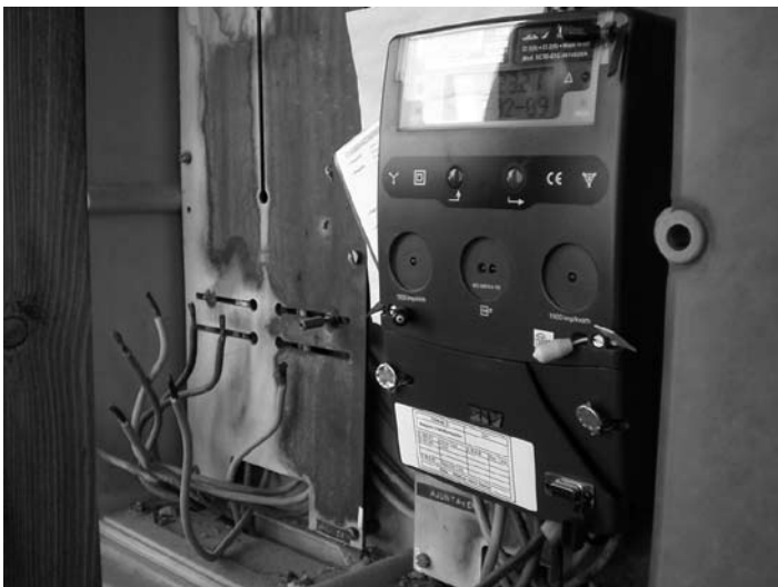
• Quadre elèctric sense protecció i amb cables lliure accessibles a qualsevol (Fotoparticular)
