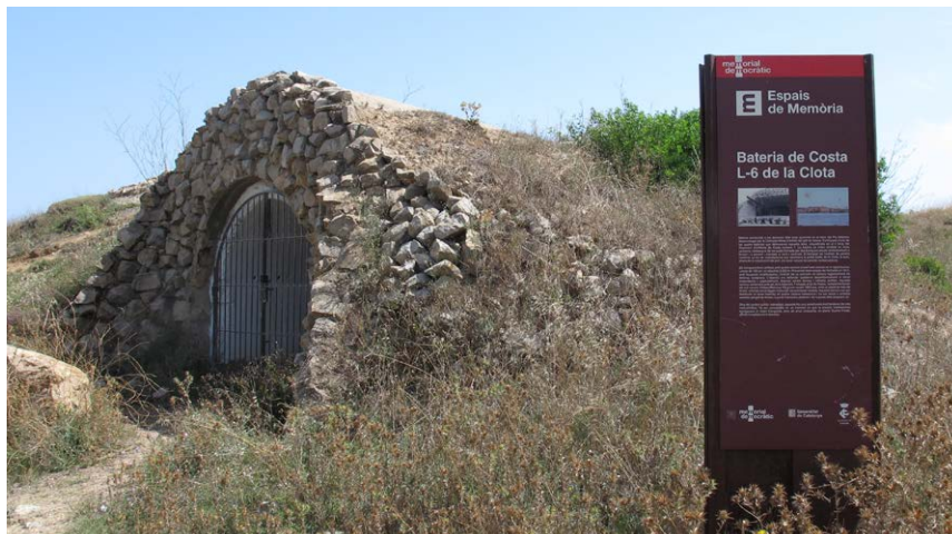
Imatge 28. Bateria de costa L6 de La Clota, l'Escala. Detall exterior. © Girona Terra Memorial.
