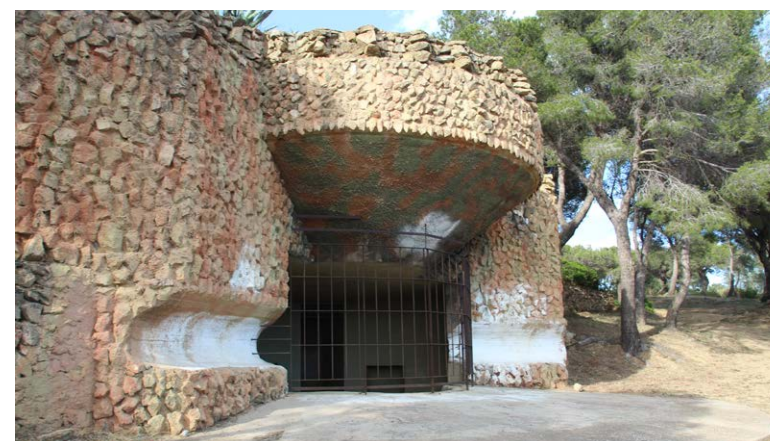
Imatge 30. Bateria de costa L8 a Punta Falconera, Roses. Detall exterior. © Aleix Guàrdia.
